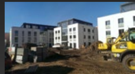
Moderne KWK-Technologie kommt in diesem Gebäude in Lichtenberg zum Einsatz.
