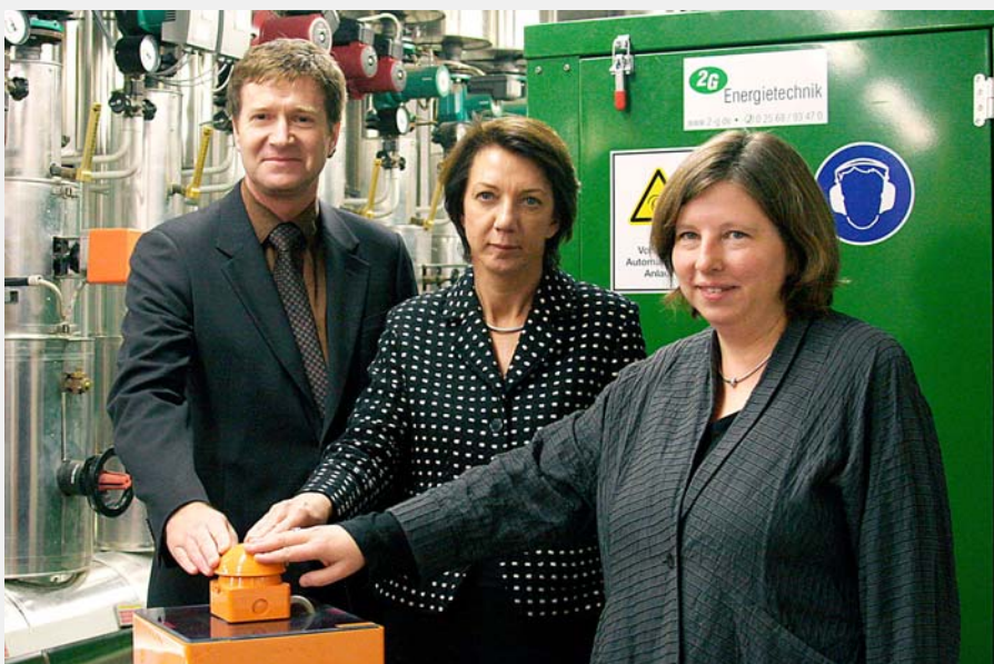
Im November 2007 wurde das neue BHKW am Betriebshof der Berliner Stadtreinigung (BSR) in Betrieb genommen. Von rechts nach links: Katrin Lompscher, Berliner Umweltsenatorin, Vera Gäde-Butzlaff, BSR-Vorstandsvorsitzende, und Michael Geißler, Geschäftsführer der Berliner Energieagentur.
