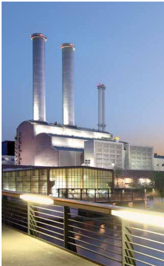
Heizkraftwerk Mitte in Berlin
