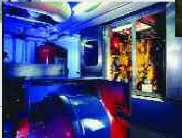
Installation von Blockheizkraftwerken zur Unterstützung und Optimierung der Wärme- und Warmwasserversorgung sowie zur Reduzierung des Strombezugs und damit des Kohlendioxid-Ausstoßes
