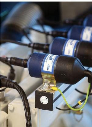
Zündung des vierzylindrigen Motorblocks eines Blockheizkraftwerks © Gust/Berliner Energieagentur GmbH
